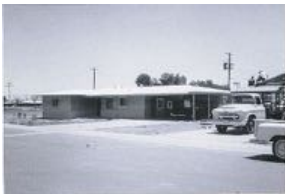
Nuestra casa en construcción en 1958
